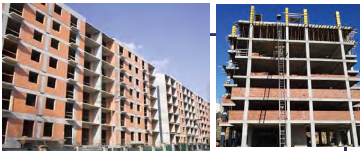
АБ конструкције за зидовима испуне
