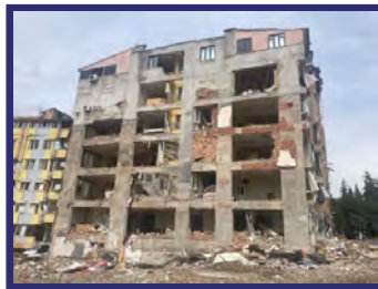
Оштећења АБ конструкција и зидова испуне у претходним земљотресима Извор: Аутор текста
