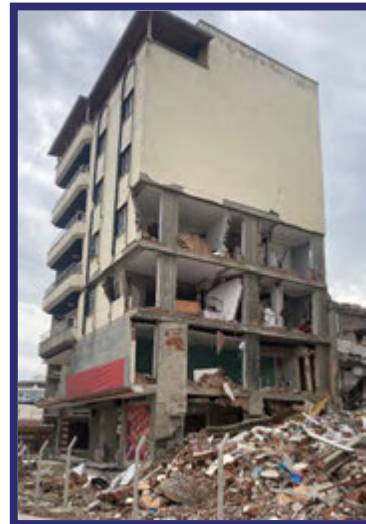
Оштећења АБ конструкција и зидова испуне у претходним земљотресима Извор: Аутор текста
