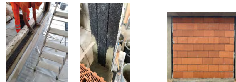
Детаљи INODIS везе и кораци извођења Извор: Аутор текста
