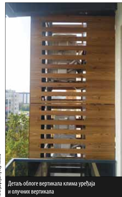
Детаљ облоге вертикала клима уређаја и олучних вертикала
