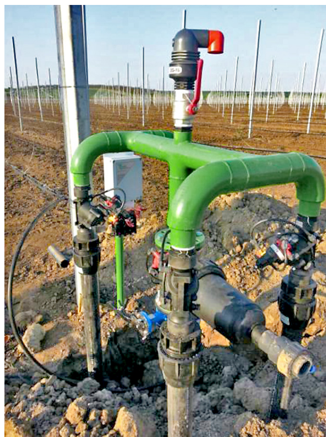
Слика 5 – извршна контролна јединица на пољу
