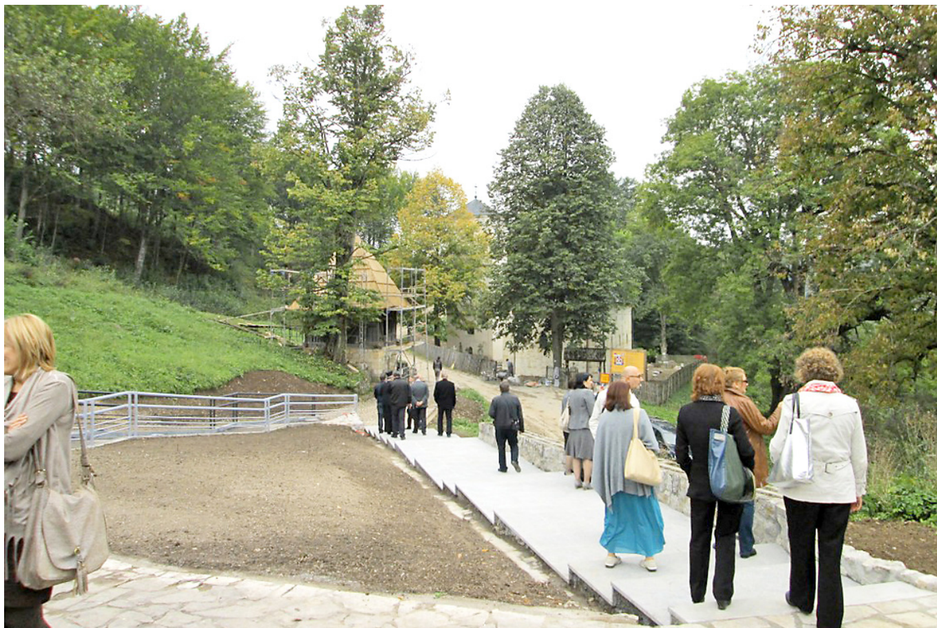
Споменичка целина Горња Добриња, извођење радова на санацији и реконструкцији
