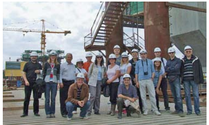
Подсекција дипломираних грађевинских инжењера организовала је посету градилишту моста Земун – Борча преко Дунава
