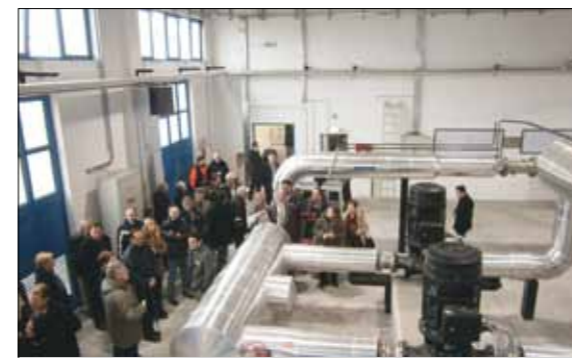
Подсекција машинских инжењера организовала је посету новоизграђеној градској топлани „Сењак“ у Пироту
