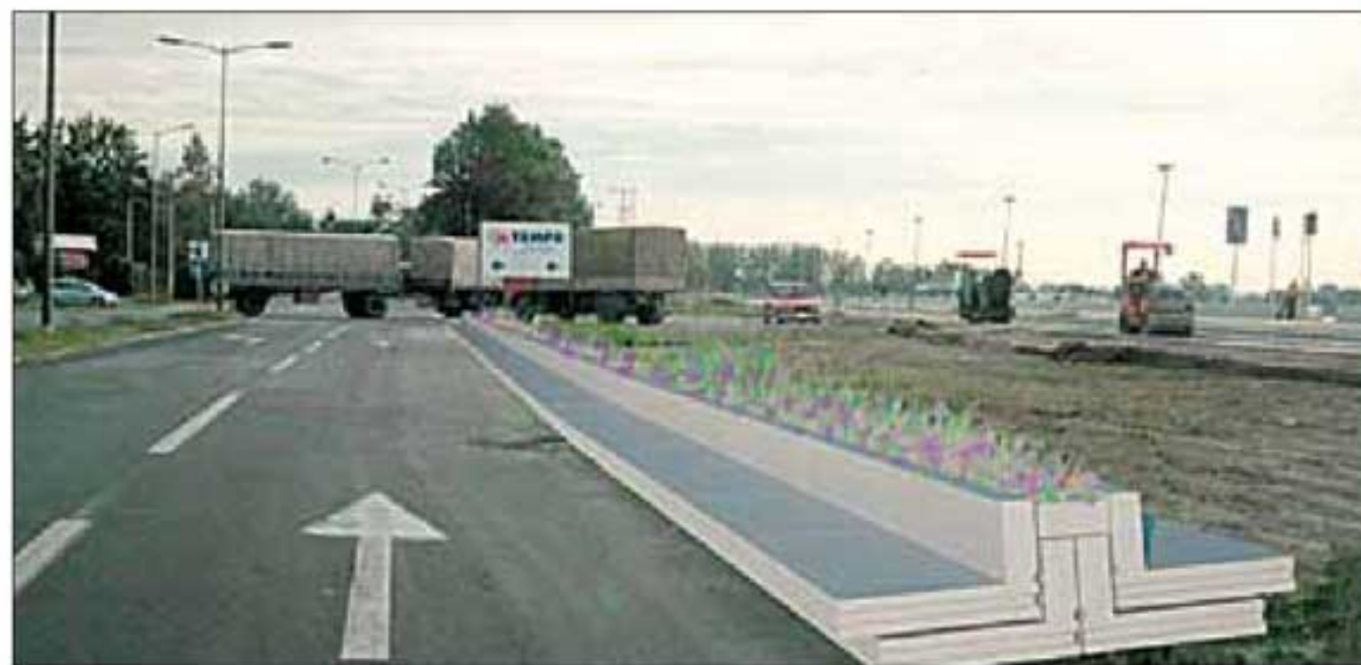
Линијско складиштење елемената крај пута – коефицијент складиштења 4:1,
