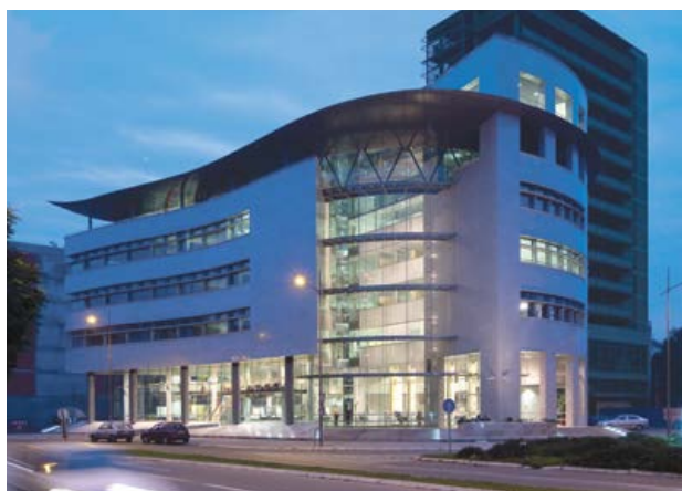
Слика 14 - Металс-банка, Нови Сад, 2008. године Фото: В. Поповић
